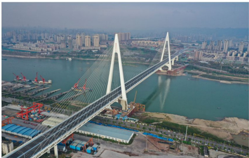
1月24日零点，由重庆市住房和城乡建设委员会组织实施，中交二航局及重庆城投集团共同投资建设的世界最大跨径轨交两用钢桁梁斜拉桥重庆白居寺长江大桥正式通车。白居寺长江大桥项目是重庆市“七横
