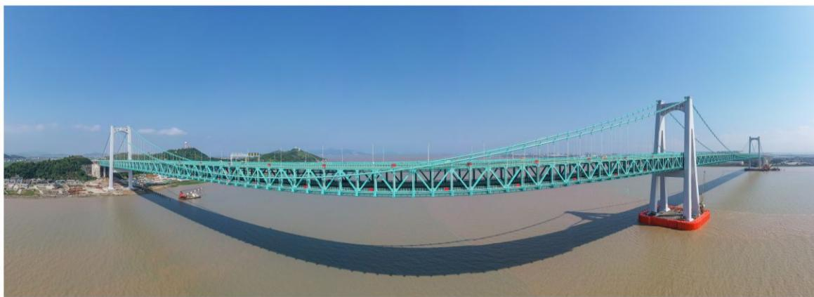
今年5月，公司参建的温州瓯江北口大桥正式通车。全长7913米、主桥长2000余米的北口大桥名片上印着三个“世界首座”——世界首座三塔四跨双层钢桁梁悬索桥、世界首例多塔连跨悬索桥大刚度混凝土中塔、世界首座强潮河口深厚淤泥质黏土超大型沉井基础。项目团队一路攻坚，实施智能建造，巧解大桥建设难题。
